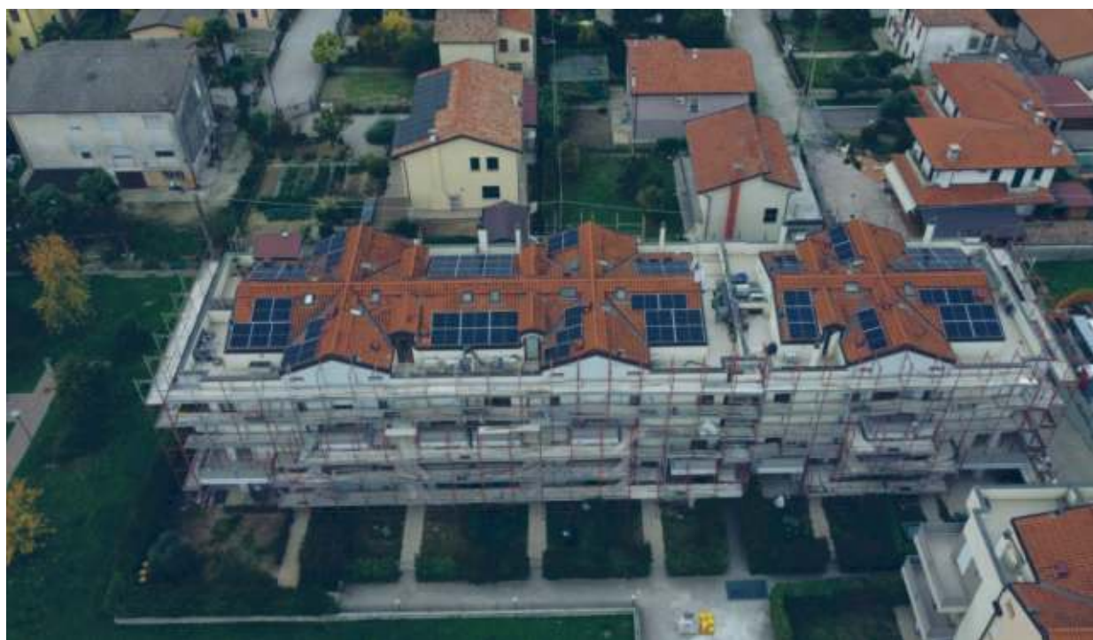
UNO DEI NUMEROSI IMPIANTI PROGETTATI E INSTALLATI DALL'IMPRESA
