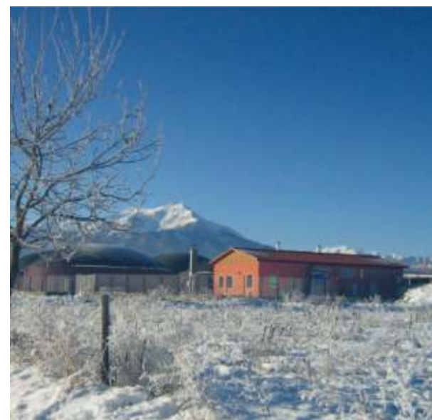
IMPIANTO BIOGAS PESIO (955 KWEL) - CHIUSA DI PESIO
