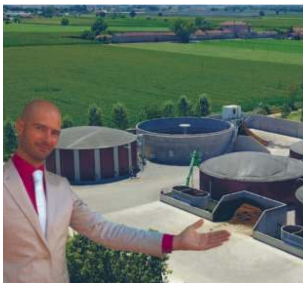
L'ING. MARIGO ED IN SFONDO L'IMPIANTO BIOGAS LA MORINA (999 KWEL) - SAVIGLIANO
